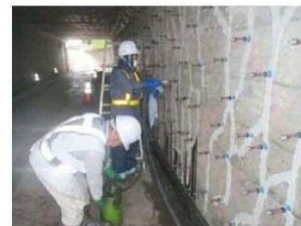
ひび割れ注入工法のイメージ
