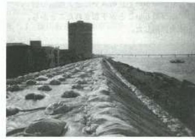
写真5.3.1 第一次緊急復旧工事
