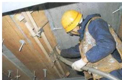
図 4.7.2-15 断面補修工のイメージ
