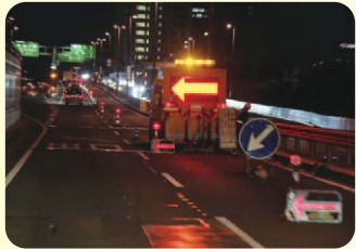
工事のための車線規制
