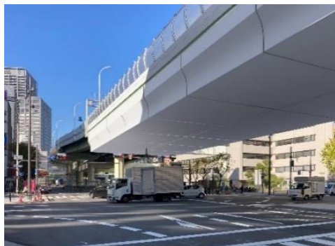
千日前付近(常設足場)
