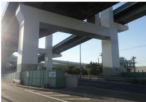
北港JCT付近
