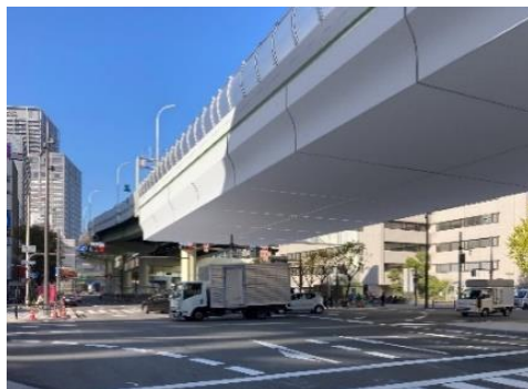
千日前付近(常設足場)
