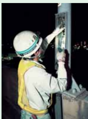
球交換や風防の清掃だけでなく、電気系統や照明柱の基礎部ボルト等も点検。
