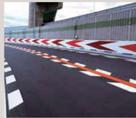
滑り止め舗装/事故データの分析から事故防止対策を提案し、その効果についてもデータによって検証します。
