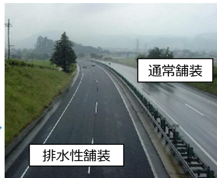
排水性舗装の例
