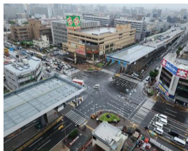
鋼製橋桁側径間 架設状況 (2024年6月)
