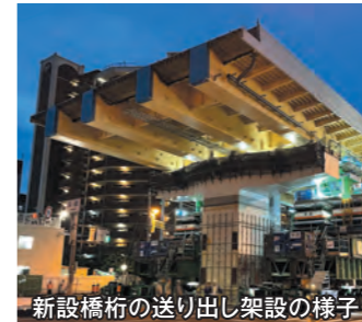
新設橋桁の送り出し架設の様子
