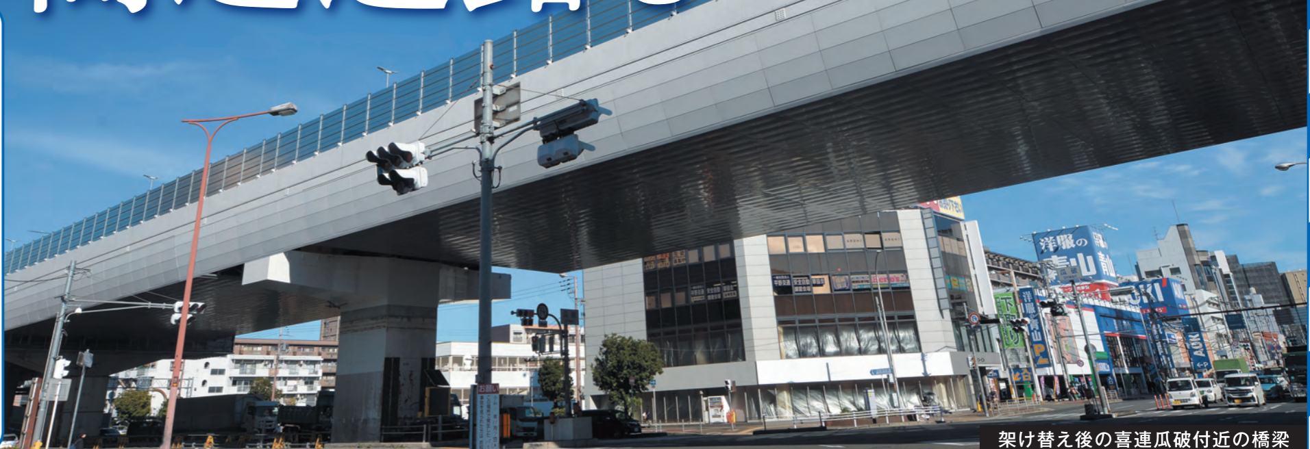
架け替え後の喜連瓜破付近の橋梁
