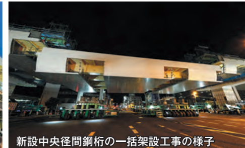
新設中央径間鋼桁の一括架設工事の様子
