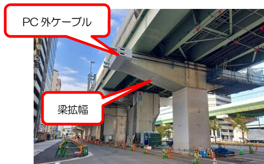
コンクリート橋脚の梁拡幅状況
