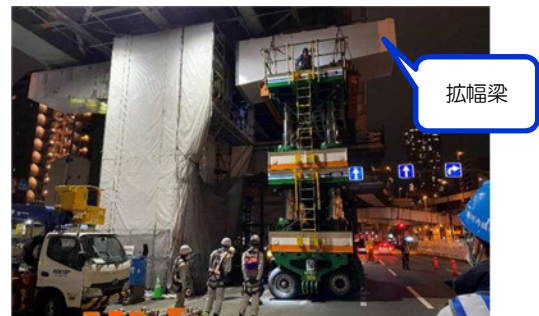
鋼製橋脚の拡幅梁架設状況
