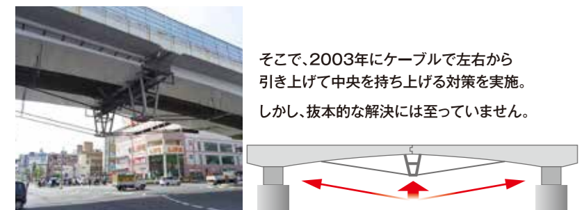
橋桁の中央付近が設計時の想定よりも大きく沈下
