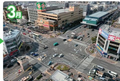
中間橋脚上の張り出し足場を撤去し、既設橋脚が柱部だけになったことで、瓜破交差点上の空間がかなり開けました
