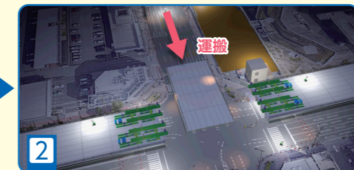
多軸台車を用いて中央の新設橋桁を施工ヤードから交差点の真ん中まで運搬します
