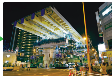
6月1日に実施した南側の新設橋桁架設の様子です。瓜破交差点を21時～翌7時の10時間通行止めにし、送り出し工法による架設を行いました。6月15日にも同様の工事を実施し、北側の新設橋桁の架設を行いました。
