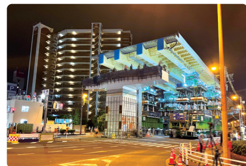
6月1日に実施した南側の新設橋桁架設の様子です。瓜破交差点を21時～翌7時の10時間通行止めにし、送り出し工法による架設を行いました。6月15日にも同様の工事を実施し、北側の新設橋桁の架設を行いました。
