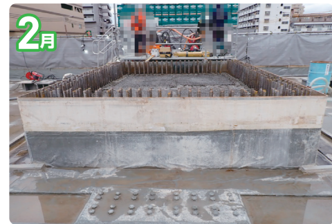
既設橋脚頭部の撤去が完了しました
