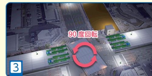
中央の新設橋桁を90度回転させ、向きを合わせます
