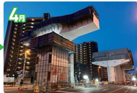
新しい鋼製の新設橋脚（梁部）の2脚同時架設が完了しました
