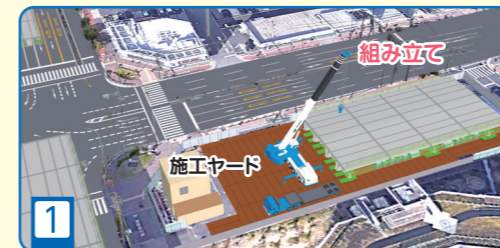
施工ヤードで中央の新設橋桁を組み立てていきます
