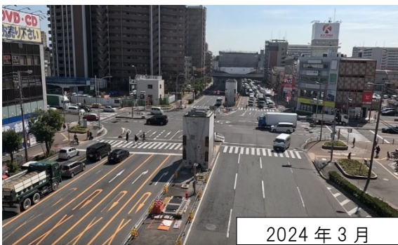
③既設橋桁及び橋脚頭部の撤去が完了
