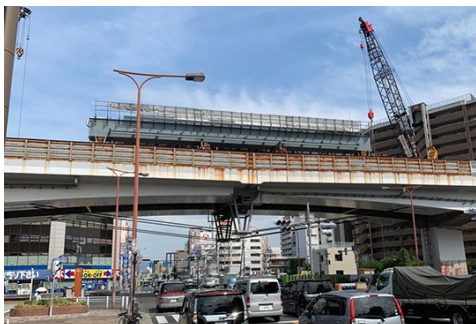
【高速道路上のクレーンによる仮設桁設置】
