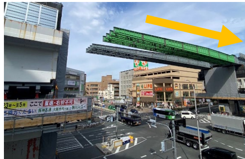
【上下線の仮設桁を一括撤去（※撤去は夜間に実施）】
