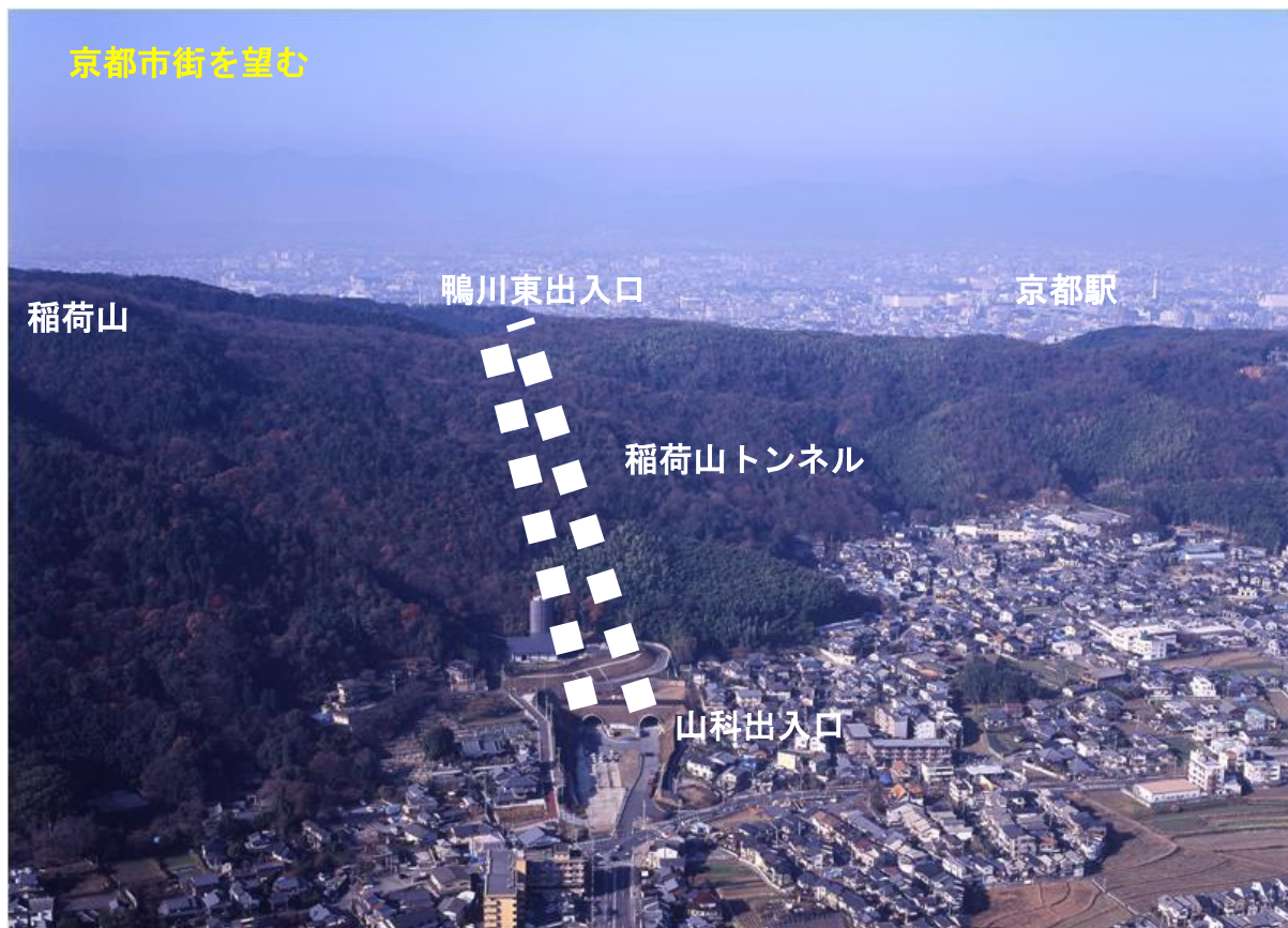
【8号京都線(稲荷山トンネル) 山科出入口上空 平成19年12月撮影】
