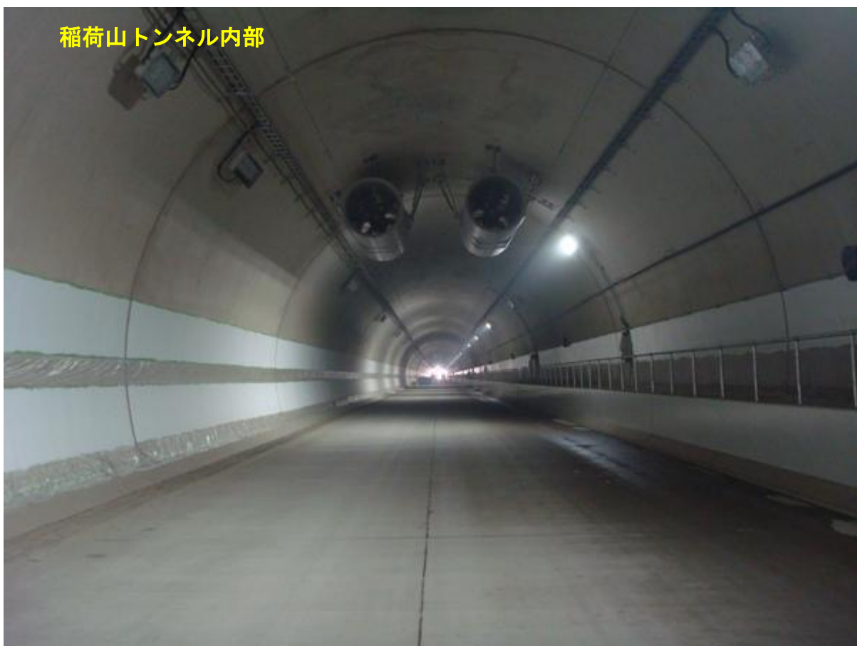
【8号京都線 稲荷山トンネル内部 平成20年3月撮影】
