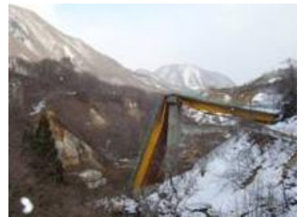
国道342号 祭時(まつるべ)大橋
