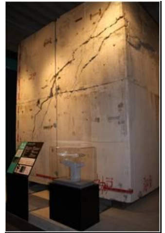
阪神高速被災構造物(震災資料保管庫内)
