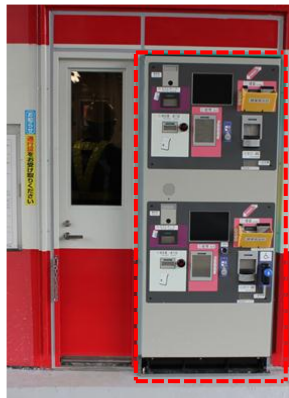
設置後【有馬口料金所】 (点線部が新設の自動收受機)
