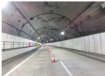
取替後のトンネル(西行)内景
