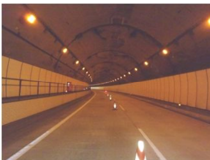
取替前のトンネル(西行)内景
