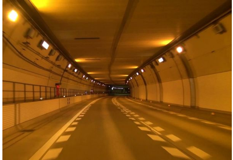
天井板設置状況
